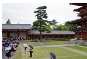
雨の薬師寺 東塔は修理中
