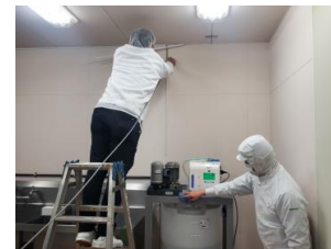
設置工事の様子
