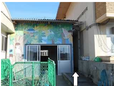
昇降口と校舎の間に隙間ができる
