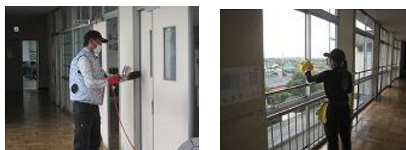
【光触媒コーティング作業のようす 8/21】
